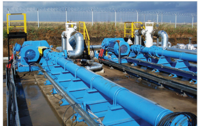
Рис. 3 — Мультифазные винтовые насосные установки У1НВ1-268.3.035.4000 в Республике Татарстан на пуско-наладочных работах
