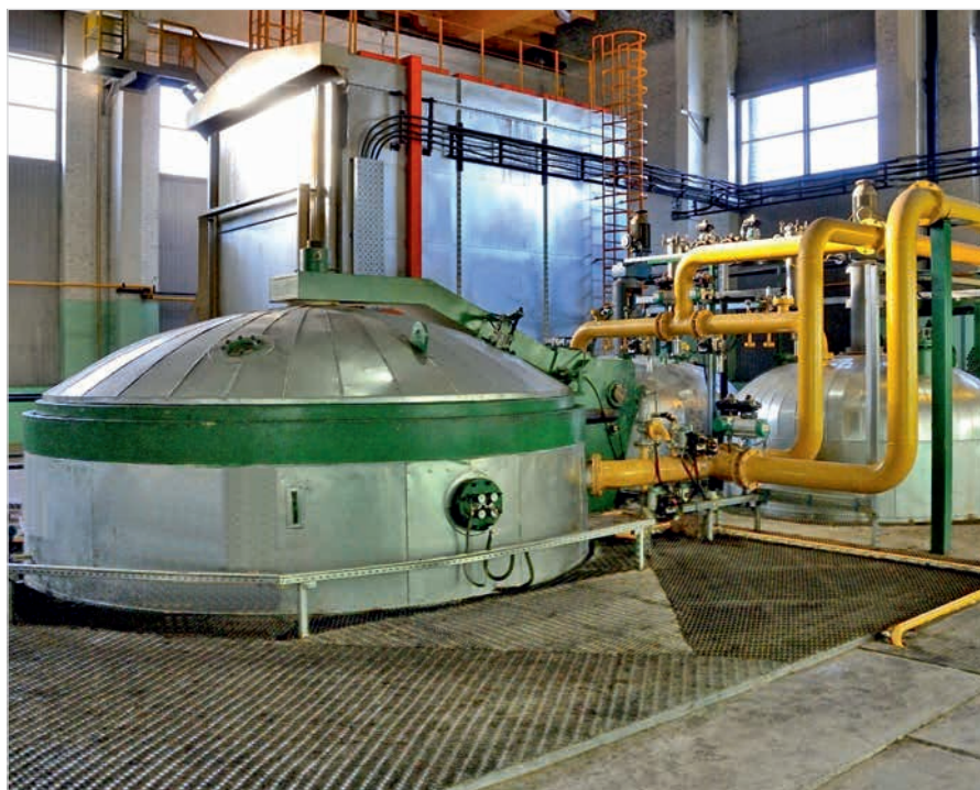
Фото 2. Вакуумно-нагнетательный пропиточный комплекс «Монолит» не имеет аналогов в России и Европе
