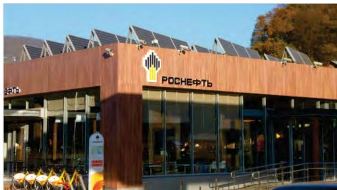
Рис. 5. Пример размещения солнечных панелей на крыше павильона АЗС
