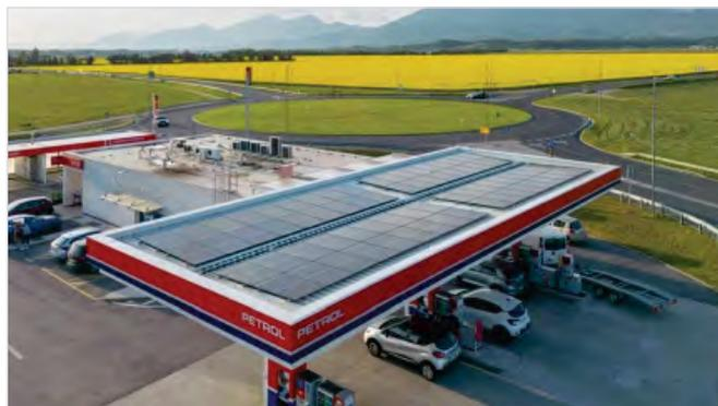
Рис. 6. Использование солнечной энергии (солнечных панелей) на АЗС компании «Petrol Group» [17]
