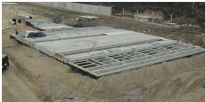
Рис. 1 — Строящиеся очистные сооружения Антипинского НПЗ
