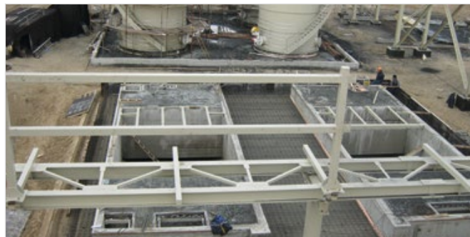
Рис. 2 — Строящиеся очистные сооружения Антипинского НПЗ
