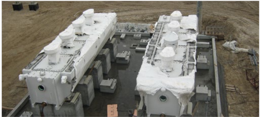
Рис. 3 — Строящиеся очистные сооружения Антипинского НПЗ
