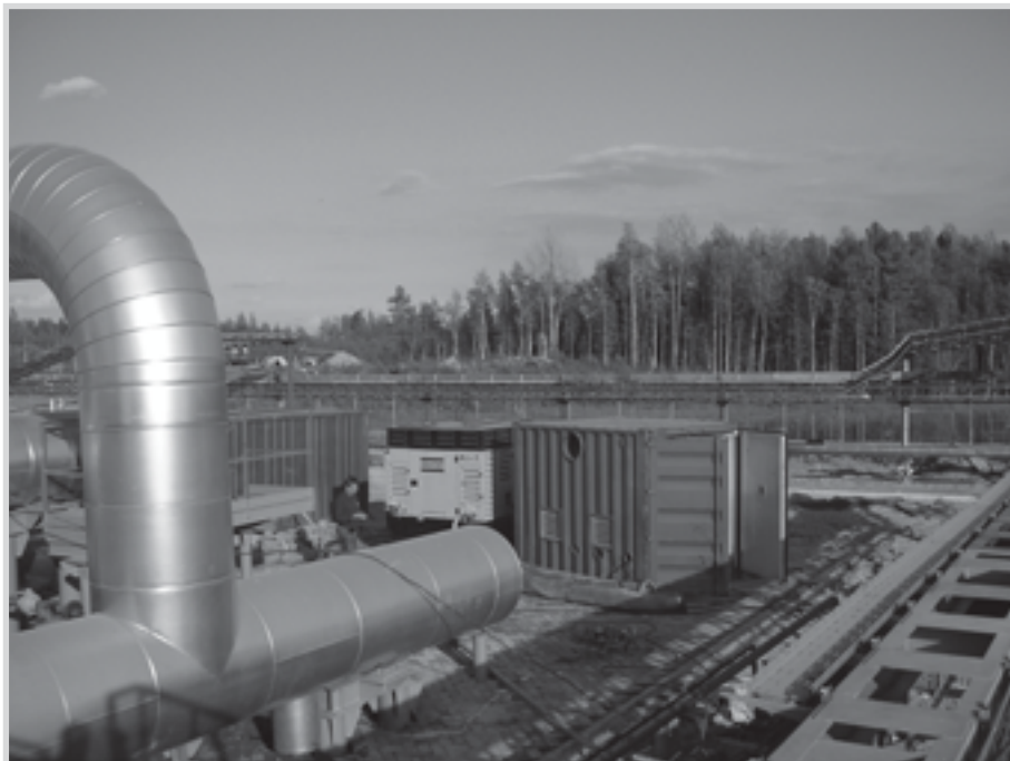
Рис. 1 Размещение оборудования ВАК на объекте производства работ
