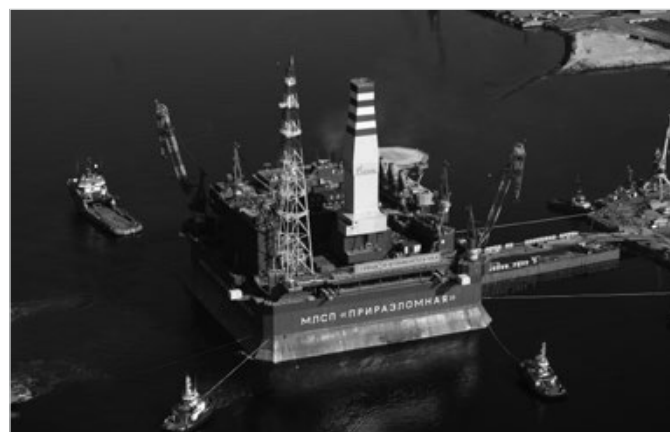
Рис. 2 — Морская стационарная ледостойкая платформа гравитационного типа на месторождении «Приразломное»
