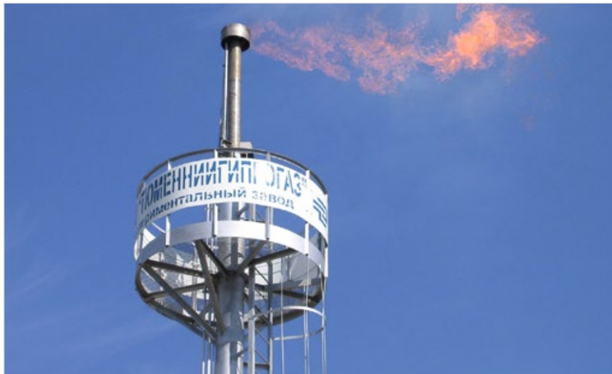
Рис. 2 — Установка УФМГ-А-150/20 ХЛ на полигоне
