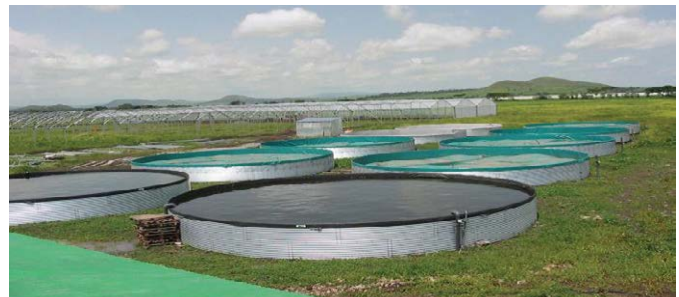
Монтаж гибридных резервуаров не требует применения специализированной техники
