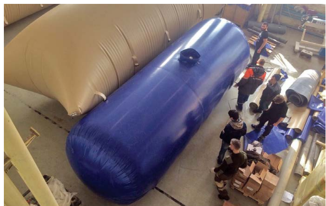
Процесс установки полимерного лайнера
