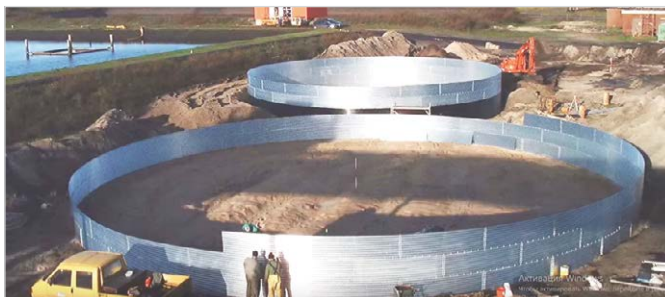
Монтаж гибридных резервуаров не требует применения специализированной техники
