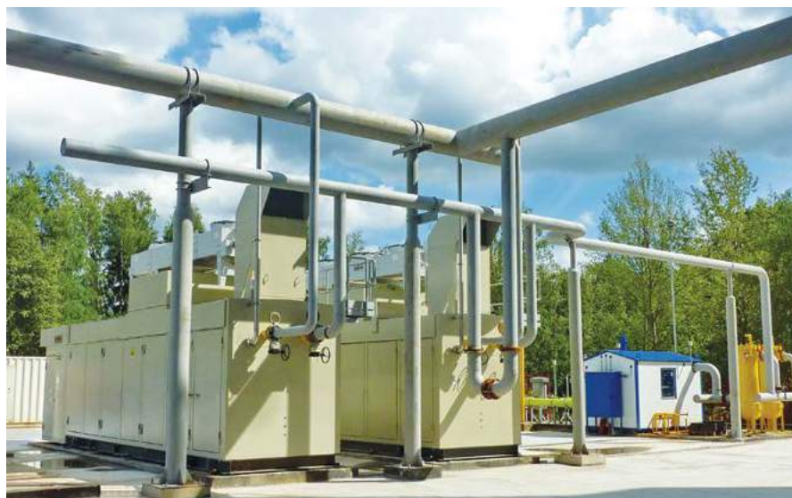
Фото 6. Система газоподготовки для автономной ГПЭС завода микроэлектроники «Ангстрем-Т»
