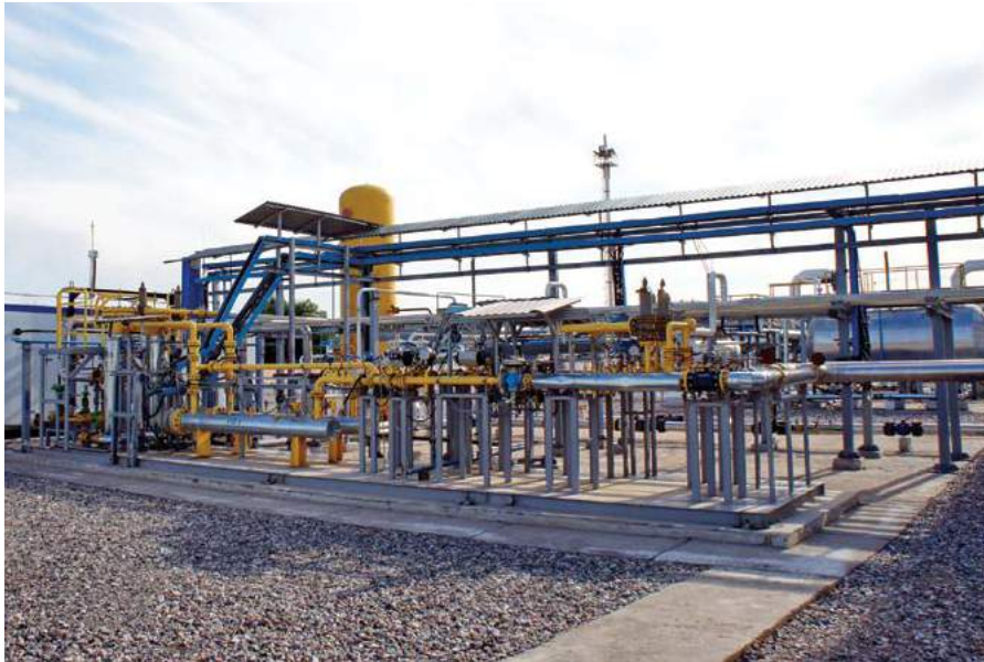
Фото 7. Система подготовки топливного и пускового газа для газоперекачивающих агрегатов ДЭС «Алан»
