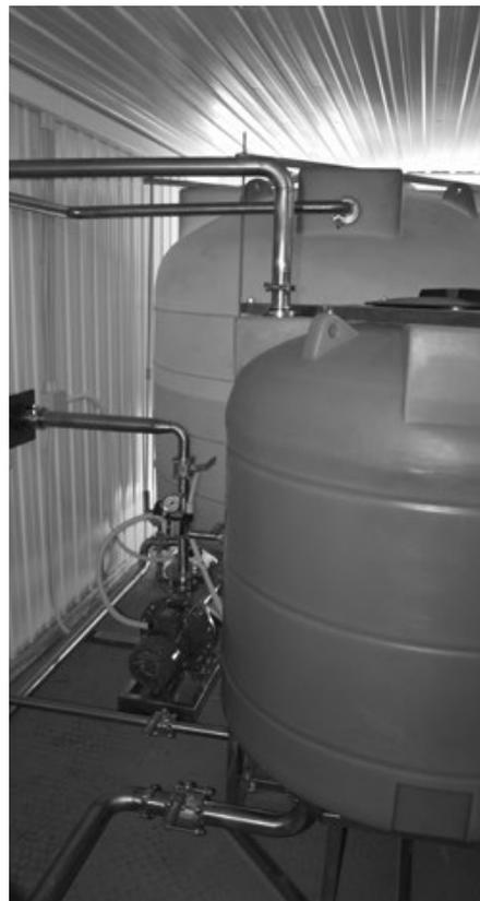
водоподготовки. При наполнении ёмкостей система водоподготовки отключается. В процессе раздачи питьевой воды уровень жидкости в ёмкостях понижается, и когда он достигает среднего уровня, система водоочистки включается и вновь происходит заполнение ёмкостей.
