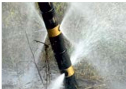
Рис. 4. Демонстрация работы гидромонитора на дневной поверхности. Производится подача пресной воды с использованием насосного агрегата СИН-32 Fig. 4. Demonstration of hydro-jetting operation at the daytime surface. Fresh water is supplied by SIN-32 pumping unit
